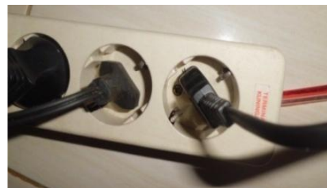
Gambar 6 Pemasangan Kabel Power
