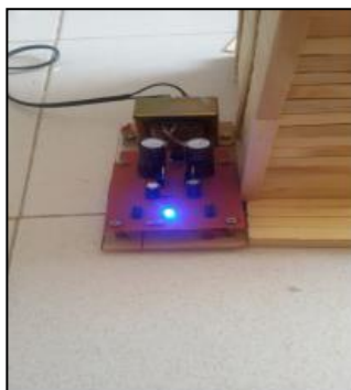
Gambar 11 : Pemasangan Power Supply
